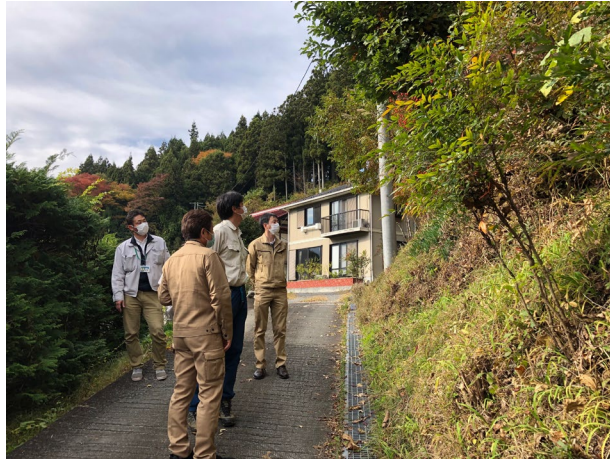
写真 3-4 361-H-009 のり面の状況
