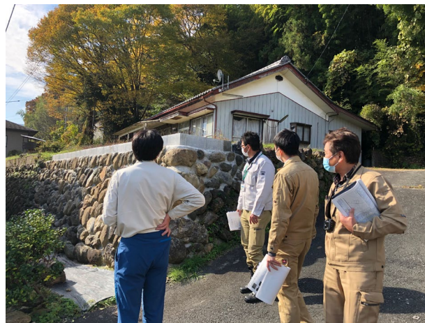
写真 3-3 361-H-008 玉石積み擁壁の状況（奥の玉石擁壁に補修跡が確認できる）
