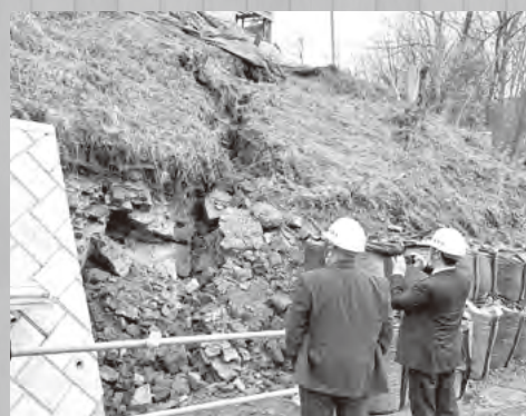
町道3307号線の土砂崩れ現場を視察
