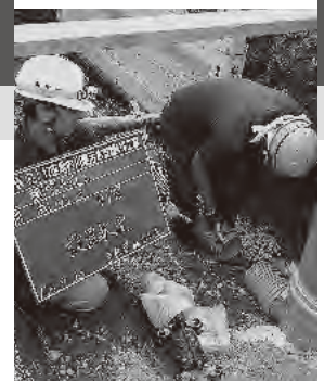
下水道管工事
