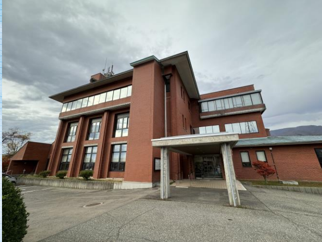
磐梯町役場(全景)
