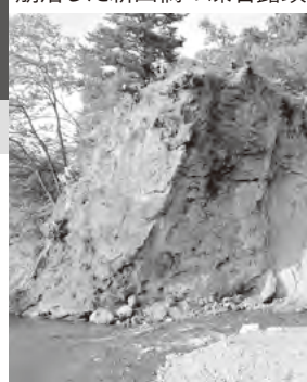
崩落した新田橋の礫岩露頭
