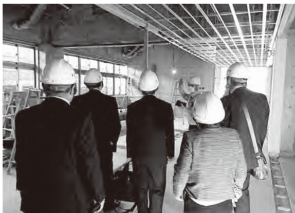
工事担当者から進捗状況について説明を受けました
