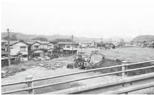
更地になった町営住宅跡地
