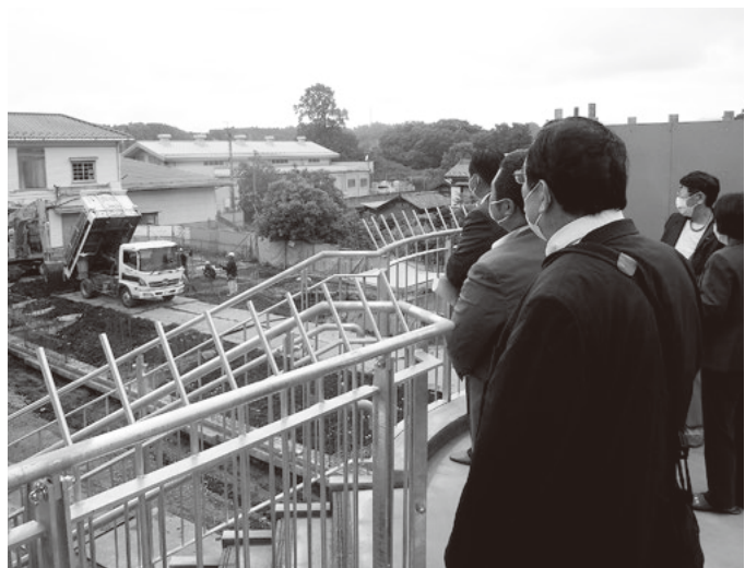
第2期工事の基礎工事が順調に進む
