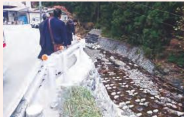
きれいになった生川護岸
