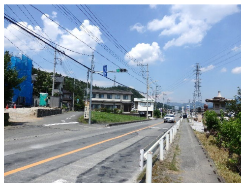
県道 11 号熊谷小川秩父線
