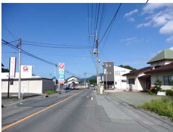
県道 11 号熊谷小川秩父線
