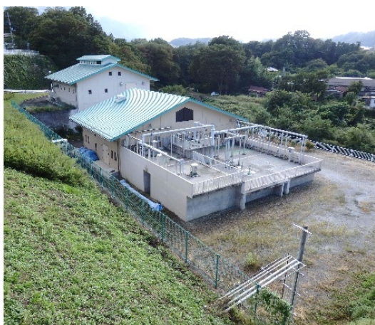
横瀬町水質管理センター
