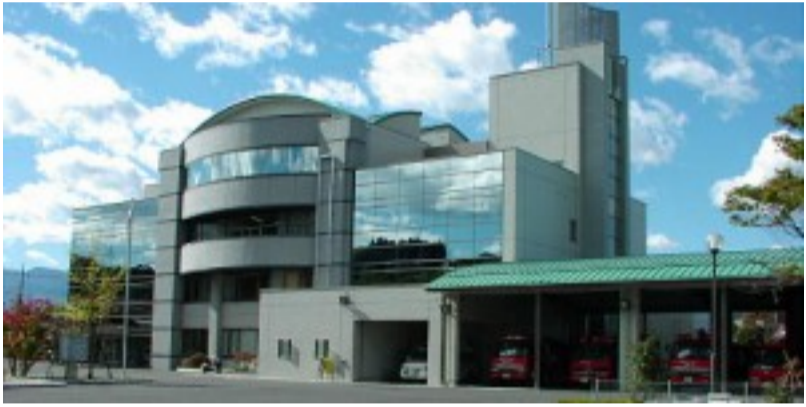
秩父消防本部庁舎全景
