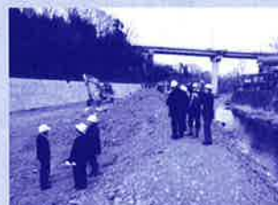
和田地区対岸の河川改修現場
