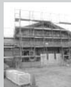
建設中の学校給食調理場
