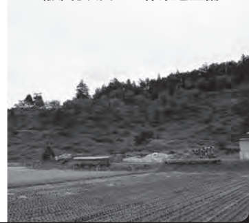
(仮)花咲山への作業道整備
