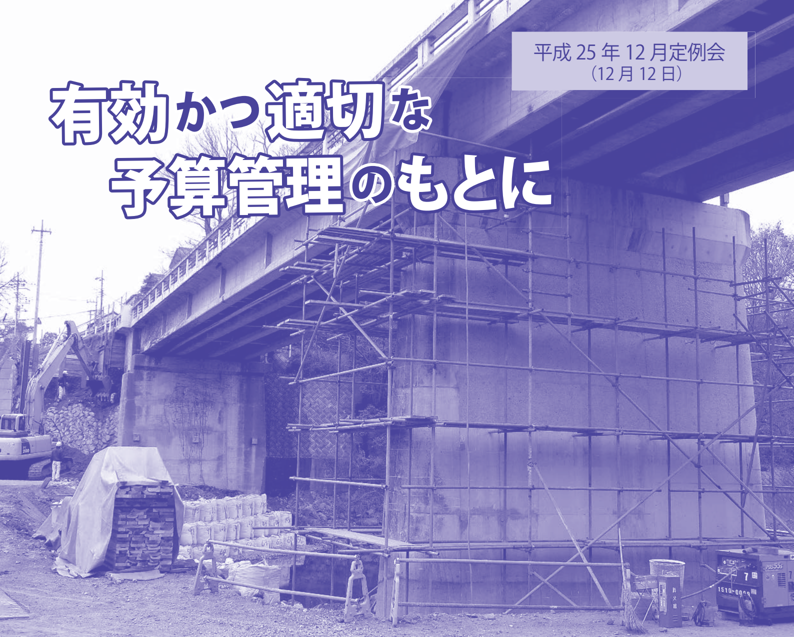
工事が進む下横瀬橋拡幅補強工事
